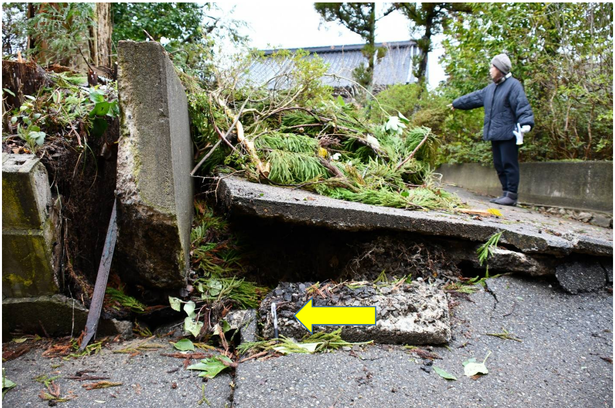
ボールペン(黄色矢印)の長さ約15cm。元は水平な路面が続いていたが、約60cmの段差が生じ、車の出入りが不可能になった(2月9日、内灘町で)
