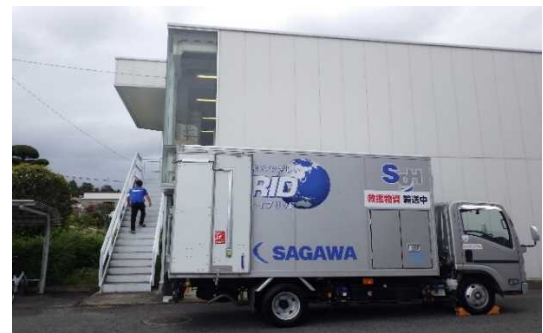
長生地域防災備蓄倉庫①
